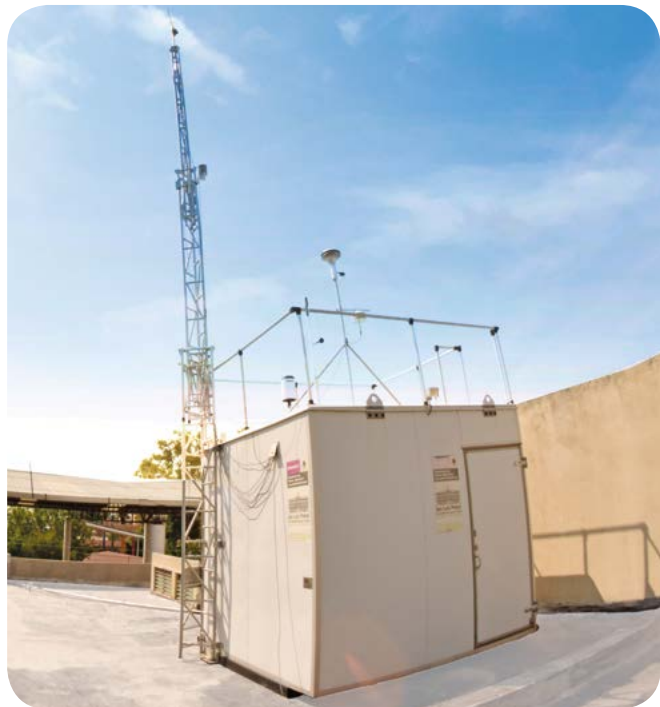
Caseta de monitoreo de la calidad del aire en la colonia Industrial Aviación.
