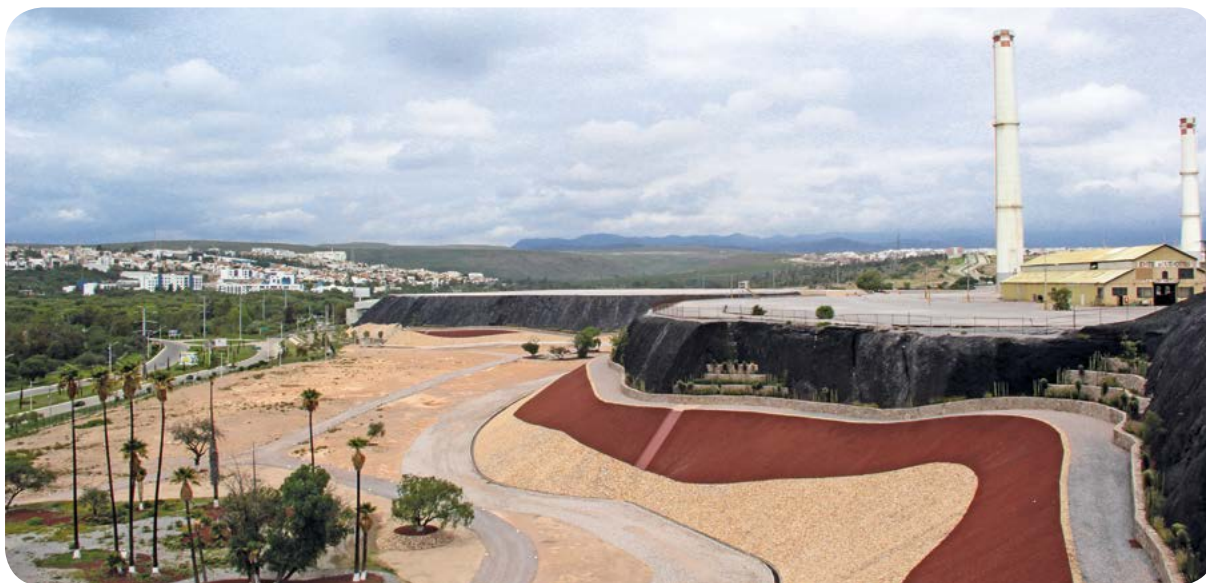
Remediación de la planta de fundición de cobre de Industrial Minera México .
